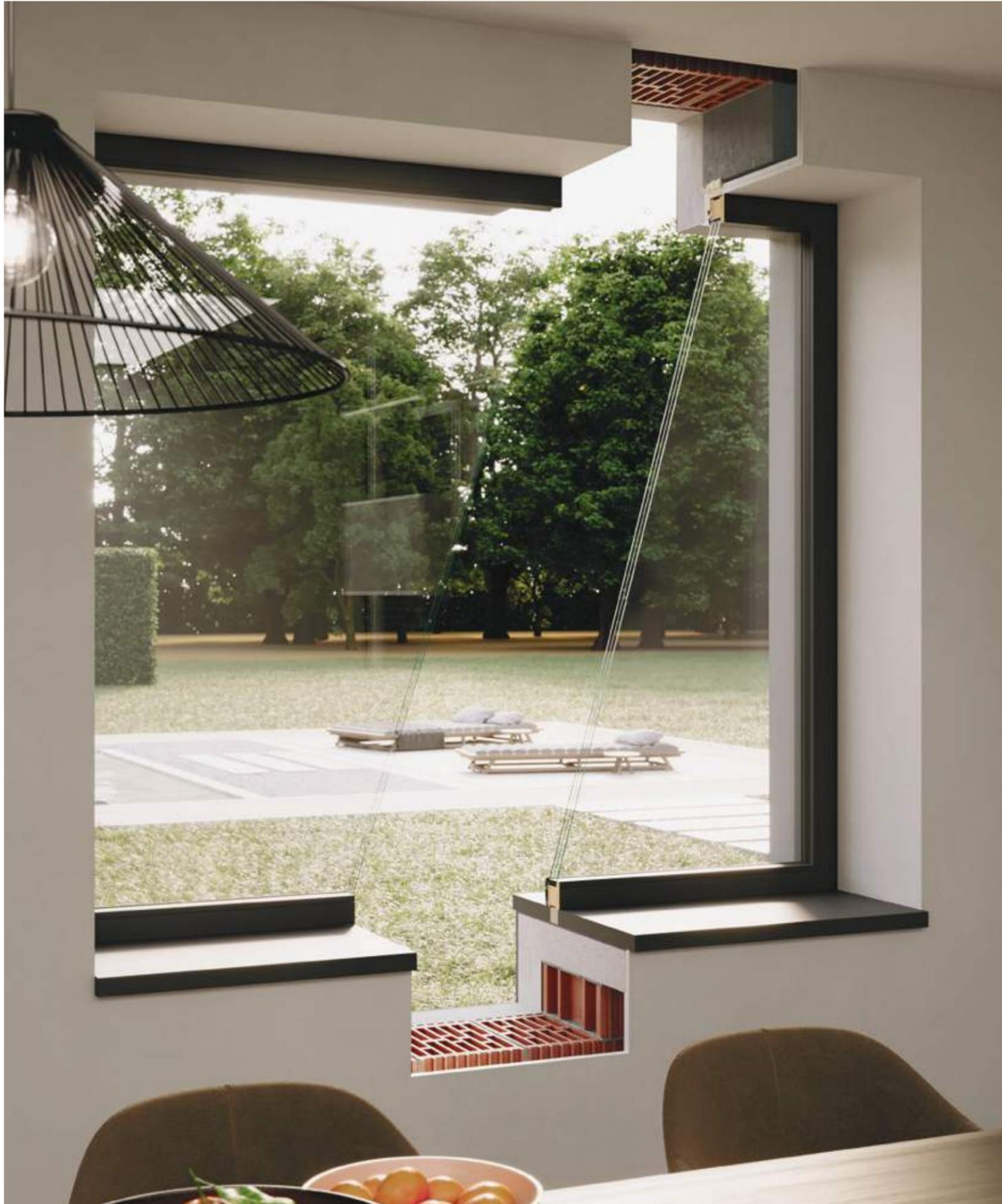
Dettaglio del falsotelaio e del traverso superiore di un serramento fisso Blend con telaio 2 installato in nicchia su muratura con controparete in cartongesso.
